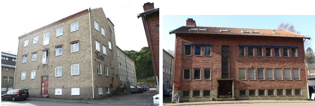
Byggnaderna på fastigheterna Krokslätt 35:5 och 35:9
